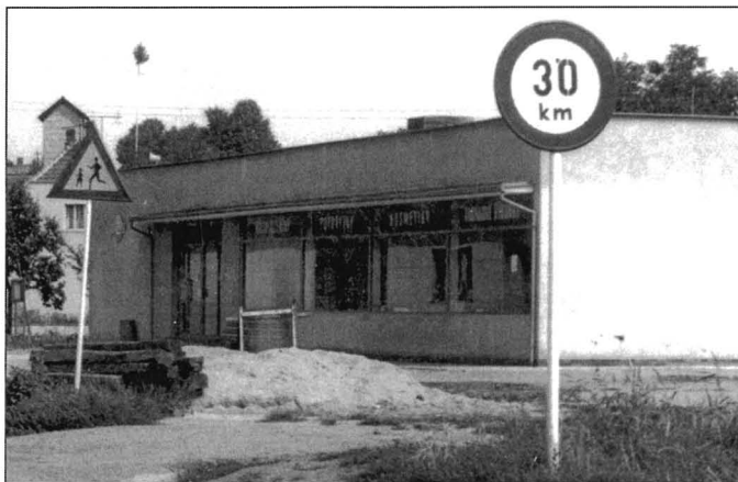
Bývalá prodejna Jednoty, nyní obchod Rostislava Hrdličky ul. Sokolská č. 237
