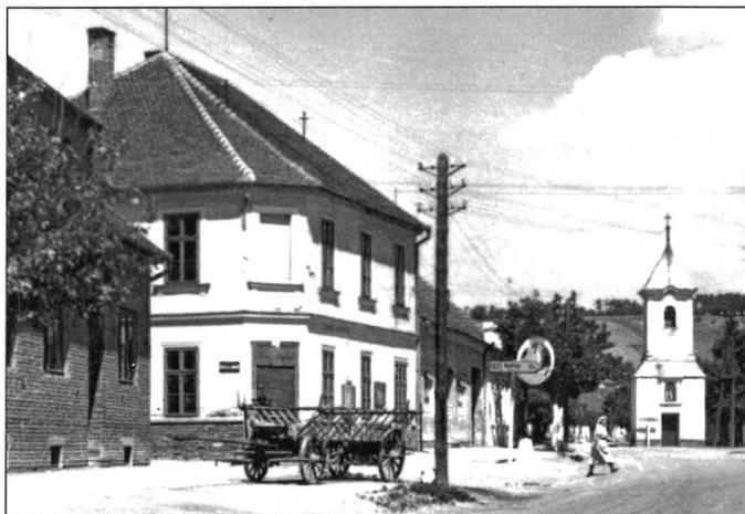
Bývalá hospoda, potom prodejna průmyslového zboží, ještě později sklad, ubytovna a v současnosti OÚ ul. Prachatičky č. 39
