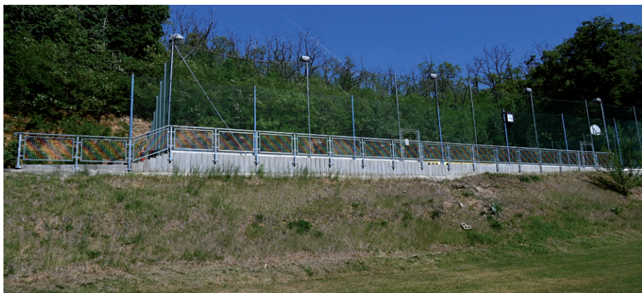
Zábradlí u víceúčelového hřiště, květen 2022.
