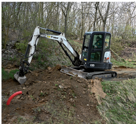
Uložení kabelu pro světlo na hřišti Pod Lipami, duben 2023.
