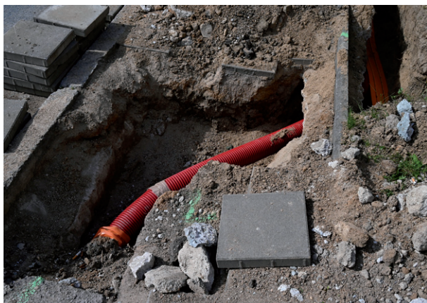
Pokládka optických kabelů, jaro 2024.
