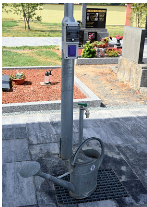
Nový kohout na napouštění konví a zásuvka na 220 V v zadní části hřbitova.
