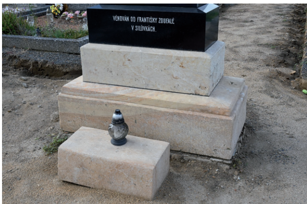
Opískování podstavce ústředního kříže hřbitova z roku 1913.
