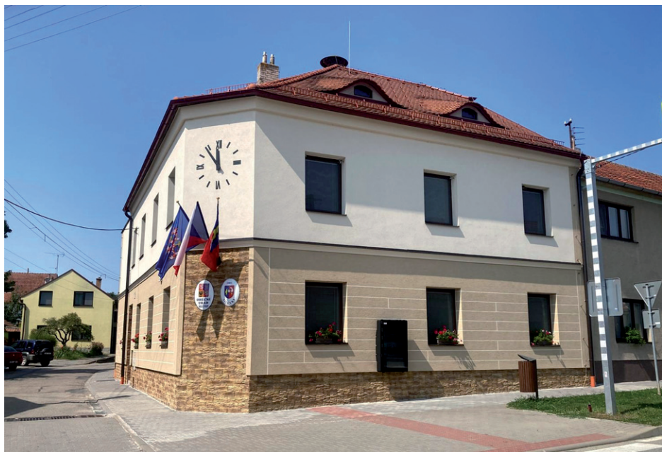
Budova OÚ po rekonstrukci včetně dokončeného nového chodníku kolem budovy a digitální úřední desky umístěné na budově.
