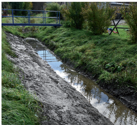
Čištění zaneseného koryta potoka Šatava na ulici Trávníky.
