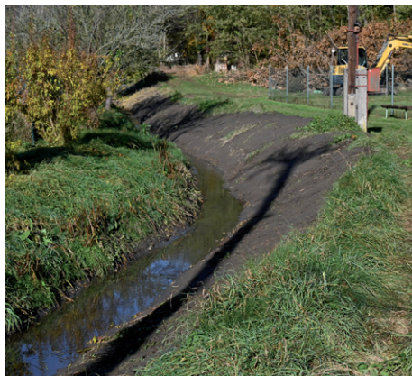
Čištění zaneseného koryta potoka Šatava na ulici Trávníky.
